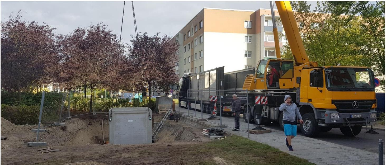
Aufgrund des Gewichts (ca. 6,0 to bei 5 m<sup>3</sup> System) erfolgt der Einbau standardmäßig durch einen 30t Kran
