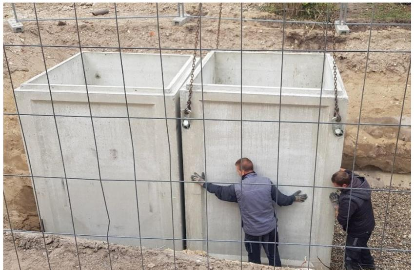
Wenn der Betonbehälter in die Baugrube gesetzt wurde, kann das Einsetzen der Unterflur-Hebebühne erfolgen:
